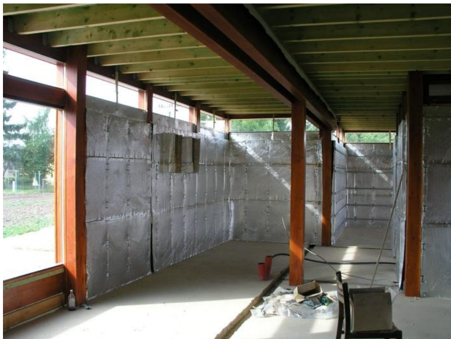
Použití izolace POLAR na rodinném domě, který je jako první v ČR zateplen bez použití klasických izolací
