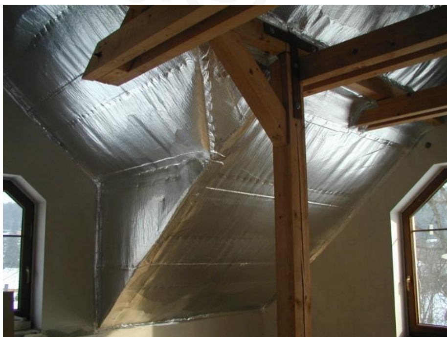
Použití izolace POLAR na rodinném domě, který je jako první v ČR zateplen bez použití klasických izolací
